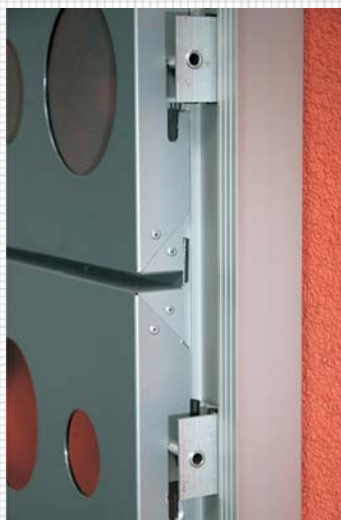
Vješanje i spajanje bond kazeta u cijelinu fasade
