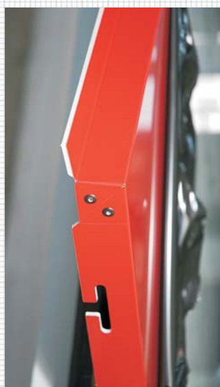
Spajanje kompozitnih ploča u kazetu pomoću zakovica
