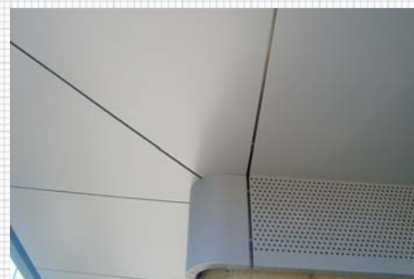
Obrada bond kazeta i limene obloge
