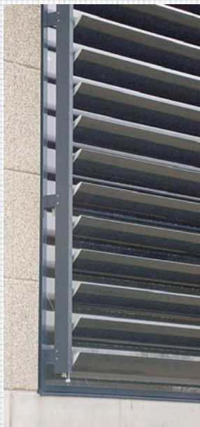
Detalji fasade sa aluminijskim brisolejima
