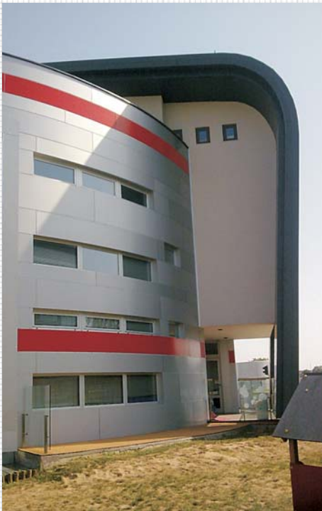
Objekt: VIP vrtić, Žitnjak, Zagreb Ventilirana bond fasada
