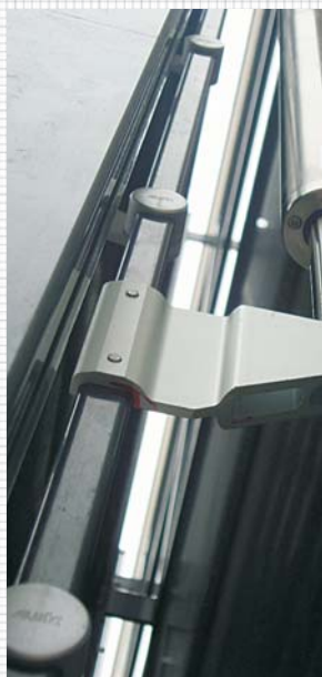
Detalji fasade sa aluminijskim brisolejima
