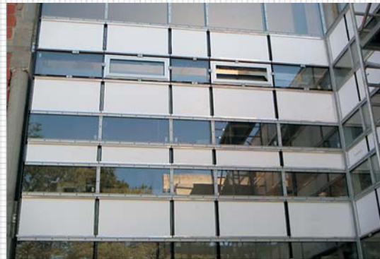
Objekt u izgradnji
