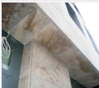
Objekt: Maksimir, Zagreb, Kamena ventilirana fasada
