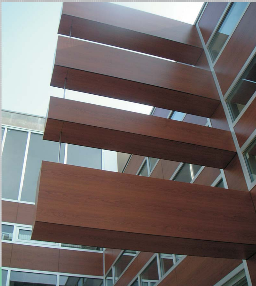
Objekt: Privatna kuća, Zagreb Max compact fasada
