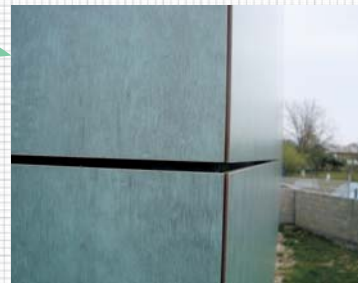
Detalj ventilirane fasade na spoju dviju fasada
