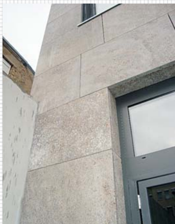
Objekt: Maksimir, Zagreb, Kamena ventilirana fasada
