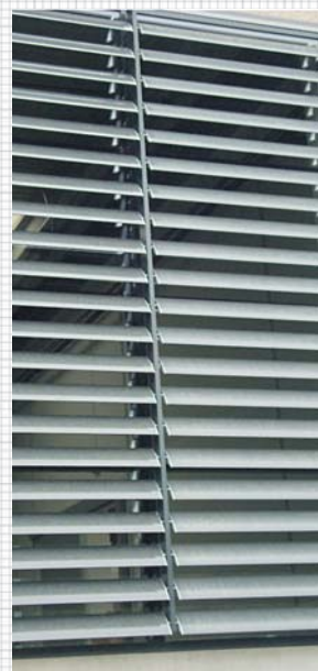
Detalji fasade sa aluminijskim brisolejima
